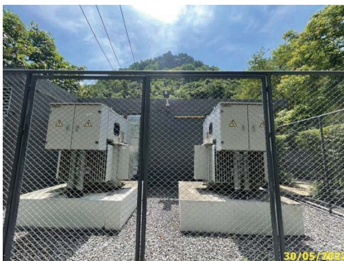
หม้อแปลงไฟฟ้าอาคารห้องเครื่อง 2
